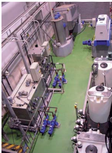
Figura 1. EDARi de la Fábrica de Helados Alacant: vista de proceso / Figure 1. Fábrica de Helados Alacant WWTP: view of process.
