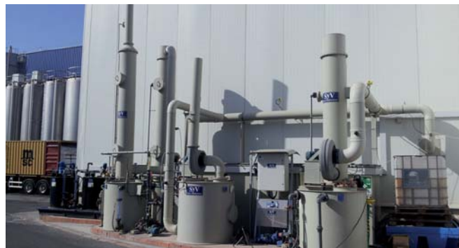
Figura 6. Vista general de las plantas piloto de desodorización en la EDAR Helados Alacant / Figure 6. General view of the odour control pilot plants at the Helados Alacant WWTP
